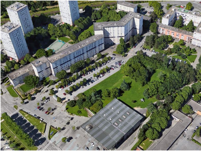
Vue aérienne du quartier avant démolition des 7 & 9 allée du Limousin
