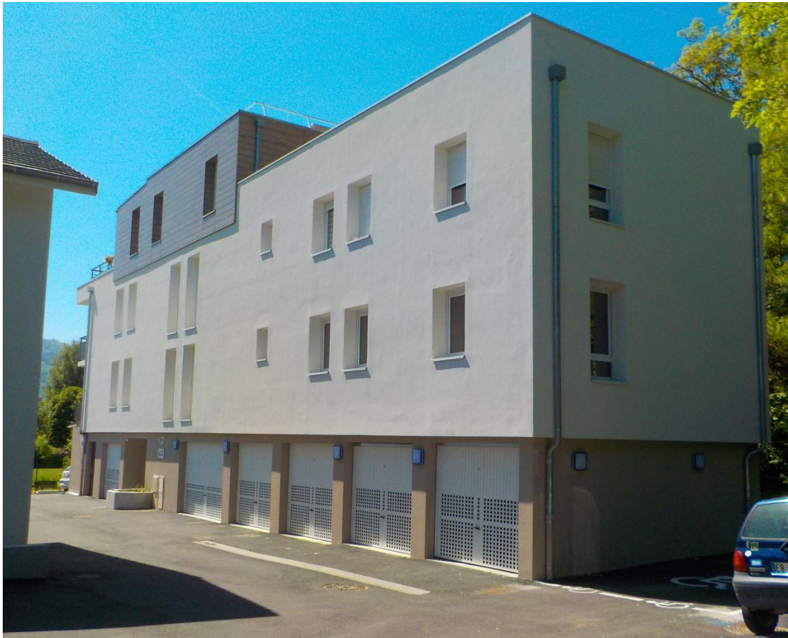
La résidence « Esprit Village » à Meylan : 11 logements locatifs sociaux dont 2 HSS
